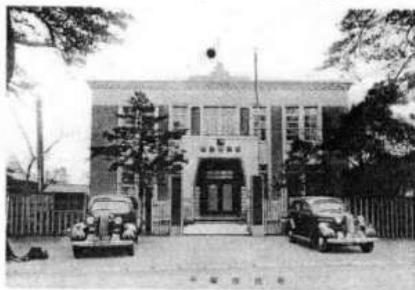
平塚市役所庁舎 昭和2年(1927) 鉄筋コンクリート造 2階建ての町役場を新築。7年に市役所庁舎となる。
