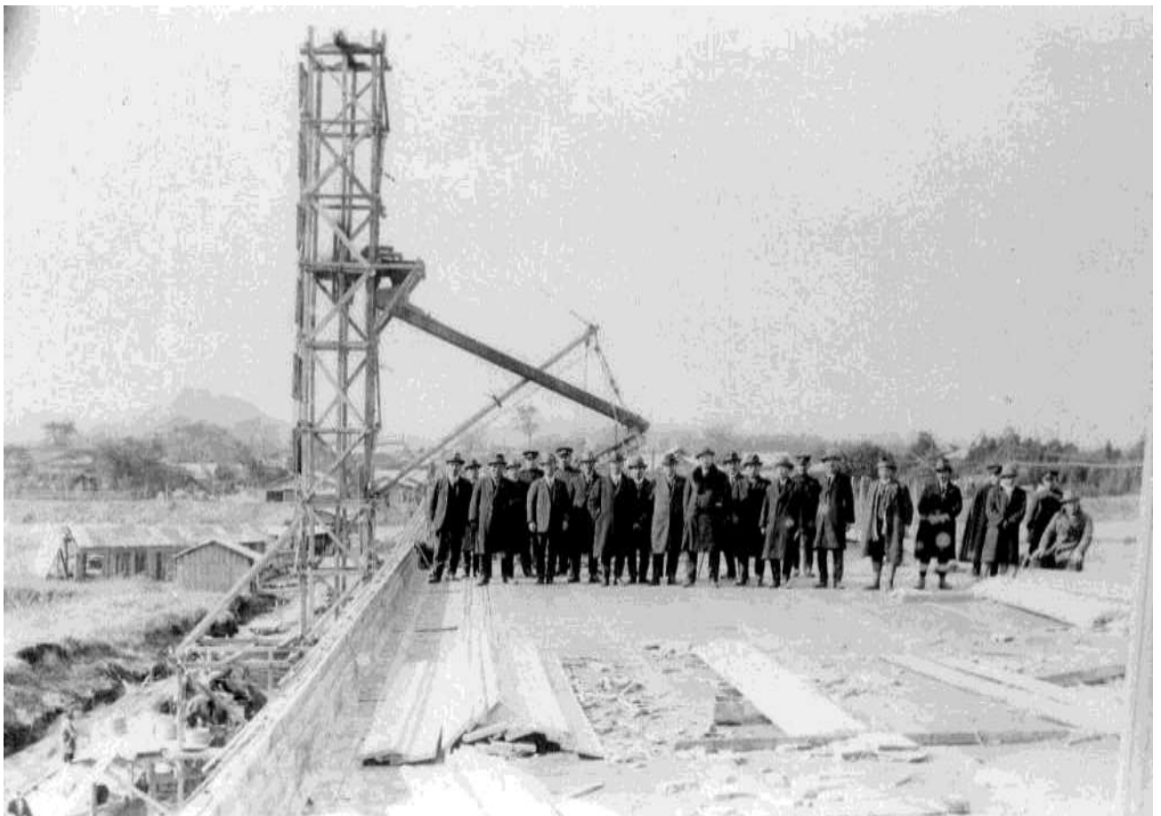
大正13年 国道1号線(東海道)馬入橋工事 宮代家が請負う
